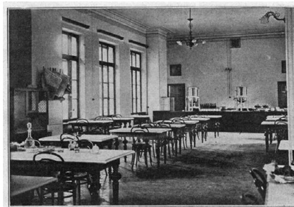
Новая столовая студентов С.-Петербургского Императорского университета. Обеденный зал и буфет. По фот. Полонского авт. «Нивы»
